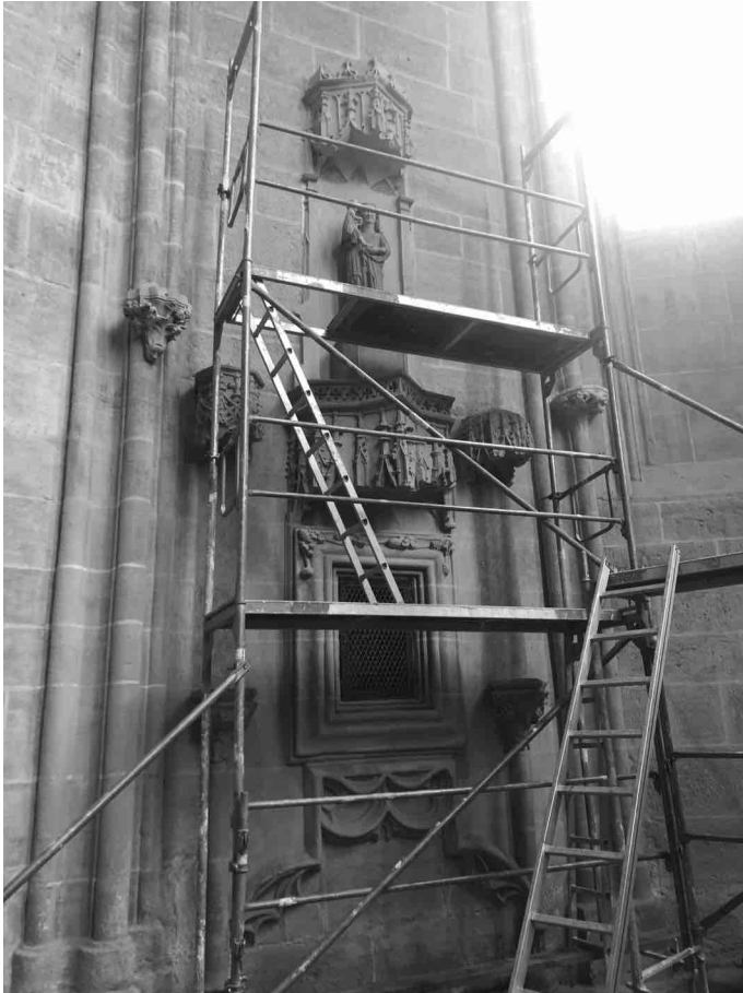
Eine schwindelerregende Arbeit auf dem hohen Gerüst vor der Madonna.
